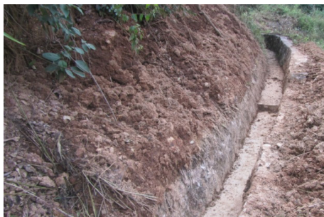
截洪沟坍塌后清理现场
