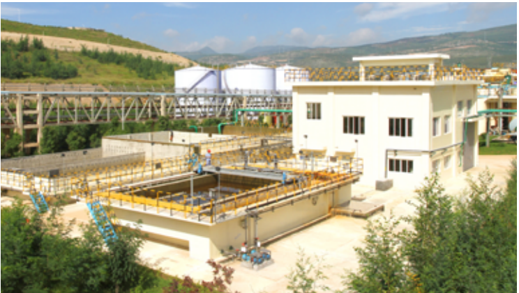
驰宏综合利用电化学水处理站
