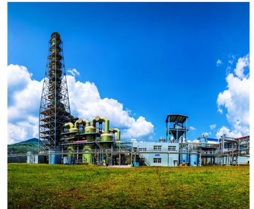
驰宏会泽冶炼建成处理量排名国内前列的含铅锌渣物料综合回收生产线之一，充分利用铅、锌冶炼互补性强的优势，将产出的浸出渣、铅渣等废弃物进行分类回收和利用，形成铅、锌、锗、银等有价值金属，实现工业固体废物100%处置与利用
