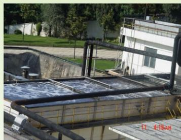
驰宏会泽矿业在国内率先实现将臭氧处理技术应用于选矿废水处理中，选矿废水全流程100%回用
